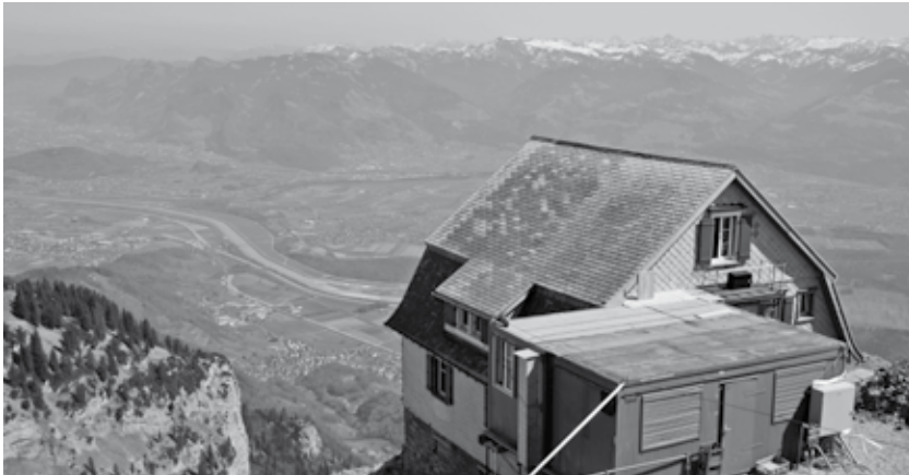
Bis zur Eröffnung des Drehrestaurants dient das alte Bettenhaus als Berggasthaus. Im Erdgeschoss finden 50 Besucher Platz, die Küche wurde in den beiden Containern untergebracht.
